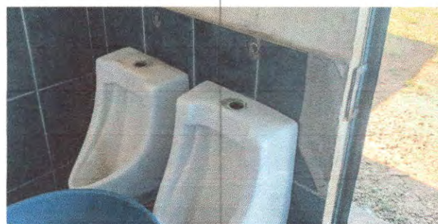
Foto 6: Sustitución de llave de mingitorio.
