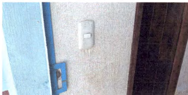
Foto 9: Sustitución de interruptores simples.
