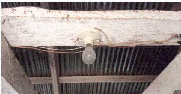
Foto 7: Sustitución de focos ahorradores.
