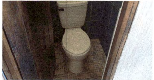
Foto 14: Instalación de inodoro.
