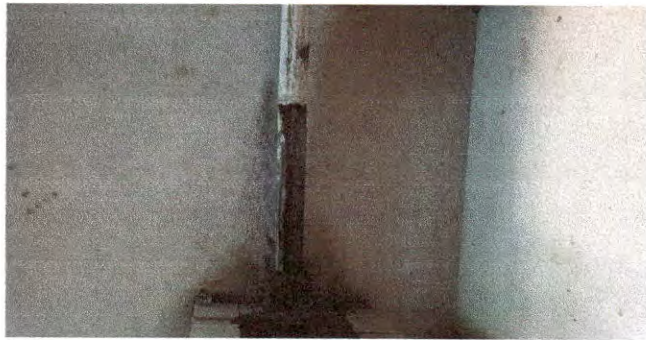
Foto 17: Sustitución e instalación de chimenea de concreto.
