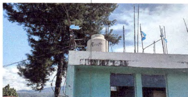
Foto 12: Sustitución de depósito de agua 1250 lt.
