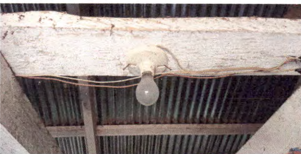
Foto 11: Sustitución de cableado eléctrico sólido.
