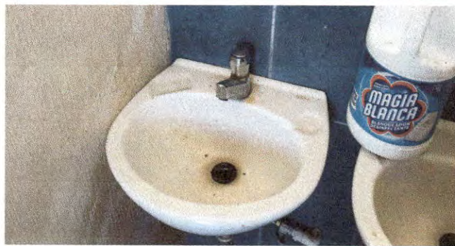
Foto 15: Instalación de lavamanos.
